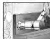
6: Anker mit dem Montage-drehmoment T_{inst} verspreizen
