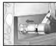
4: Anker mit dem Montage-drehmoment T_{inst} verspreizen
